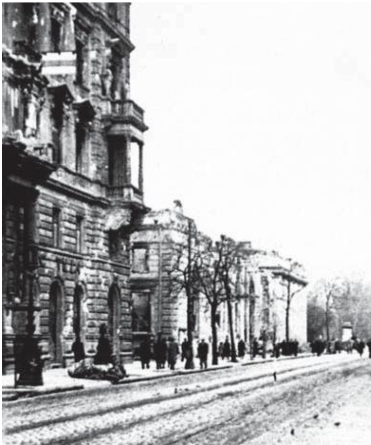
Dům č. 16 v ul. ul. Królewskiej na podzim roku 1939
